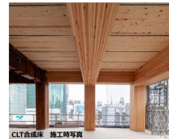
CLT合成床 施工時写真
