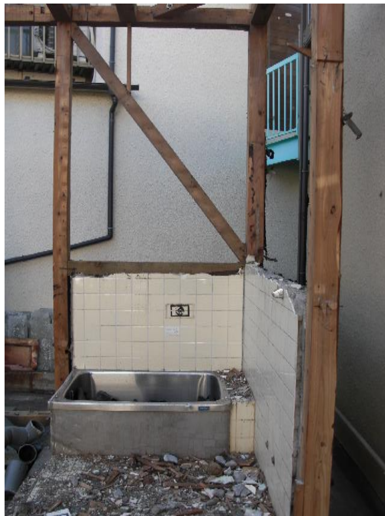
浴室のブロック腰壁
