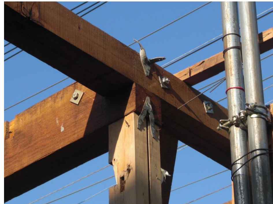
梁の小口面に打たれた VP金物
