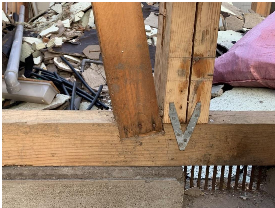
柱の直下に床下換気口
