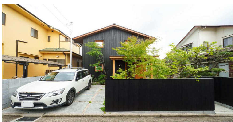
焼杉も国産材を使用。焼杉の墨色、木のサッシの橙色、庭の緑のコントラストが美しい外観となりました
