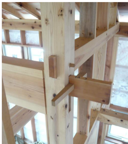
長ホゾ、込栓で組み上げた構造は大工の技。
