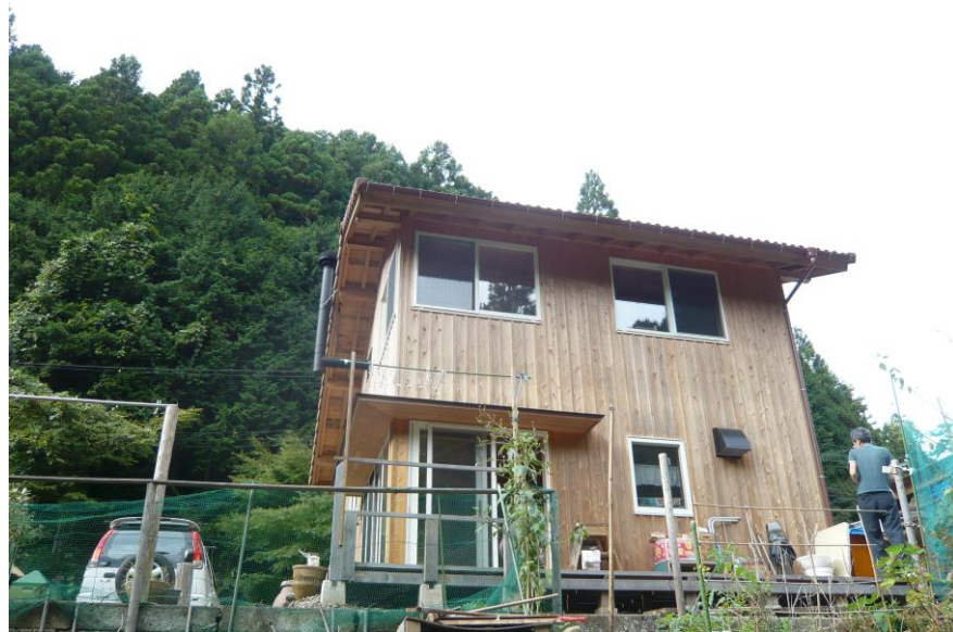
二年経ったサワラ板張りの外観。すっかり景色に溶け込んでいる。
