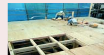
合板による根太レス工法の例
