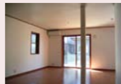
仕上材としても使えるボードによる天井クロス省略
