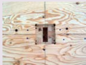
柱の欠き込みをプレカットした2階床合板
