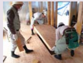
1階床合板、断熱材をパネル化する例
