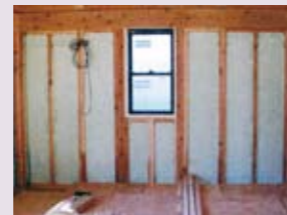
壁の断熱材、間柱をパネル化する例
