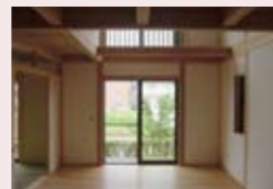
差鴨居(構造材が造作材を兼ねる例)
