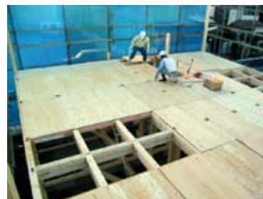
図1：根太レス工法
