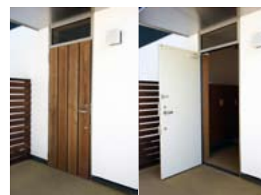
図3：既成の玄関ドアに木を貼る例
