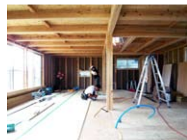
図5：床材を先行して施工している例
