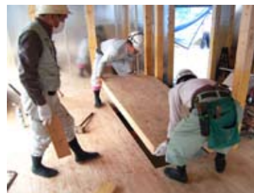
図5：1階床合板、断熱材をパネル化する例
