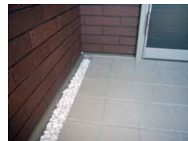
図4：規格寸法のタイルを使用する例
