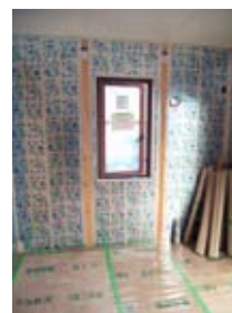
図4：小窓を組み込んでパネル化する例
