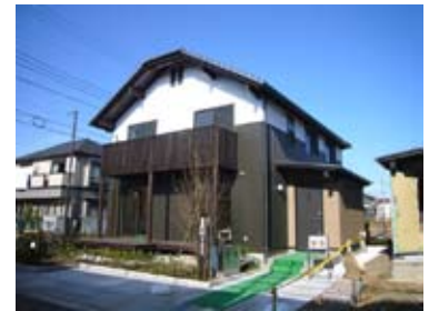
図7：腰部を4mのガルバリウム鋼板の定尺材を活用し現場での廃棄物を削減する
