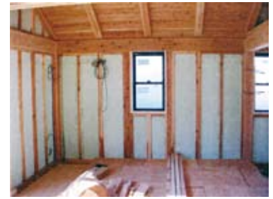
図6：断熱材・間柱のパネル化
