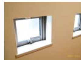
図1-2：窓枠のない窓
