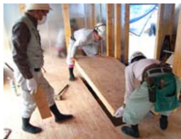
1階床合板、断熱材を パネル化する例
