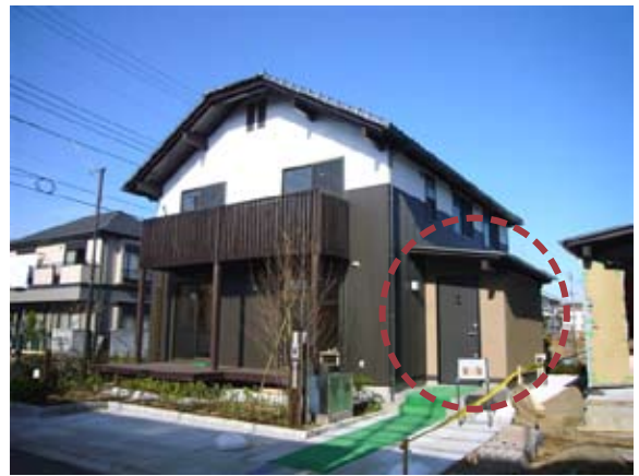
街並みや周辺の日照・通風に配慮して下屋を設ける例
