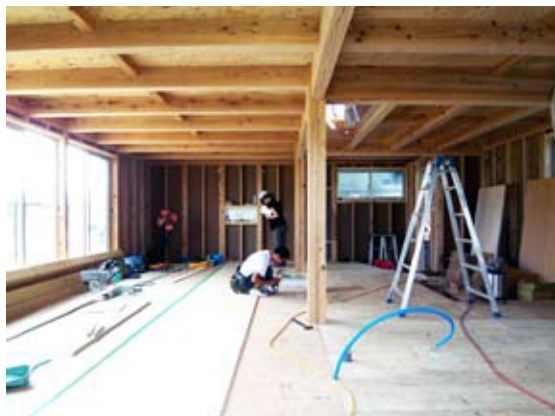
床材を先行して施工している例
