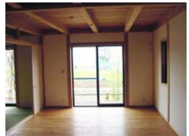
例6. 差鴨居 (構造材が造作材を兼ねる例)
