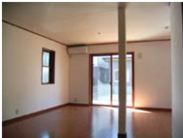
例1. 仕上材としても使えるボードによる天井クロスの省略
