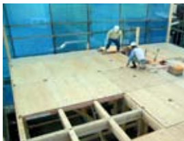
例1：合板による根太レス工法の例
