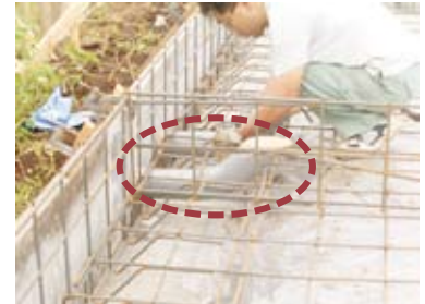
さや管により将来排水管を交換できる準備をしている例
