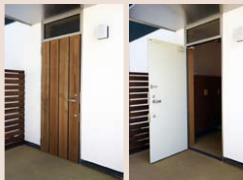
既製の玄関ドアに木を貼る例
