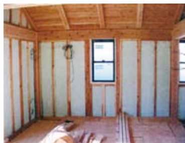
壁の断熱材、間柱を パネル化する例
