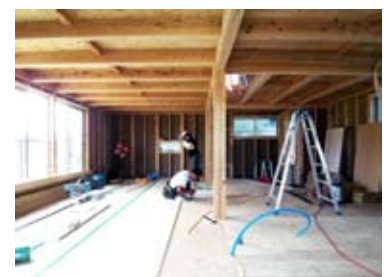
図5：床材を先行して施工している例
