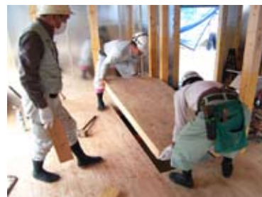
図5：1階床合板、断熱材をパネル化する例
