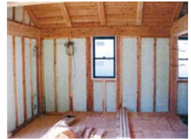
図6：断熱材・間柱のパネル化
