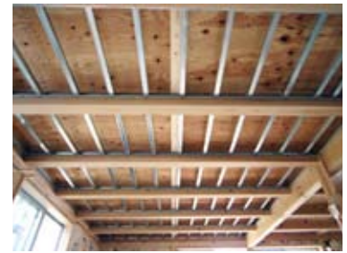
図1：軽量鉄骨野縁
