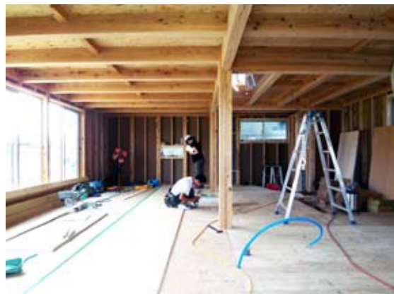
床材を先行して施工している例
