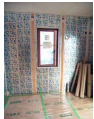
小窓を組み込んで パネル化する例
