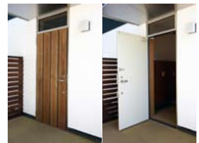
図3：既成の玄関ドアに木を貼る例
