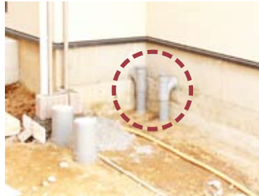
目立たない所では基礎立上り部を貫通させることも有効
