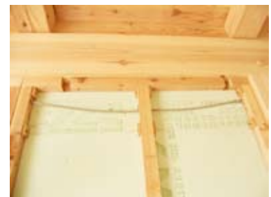
断熱材を分離しやすいよう 押縁でとめている例
