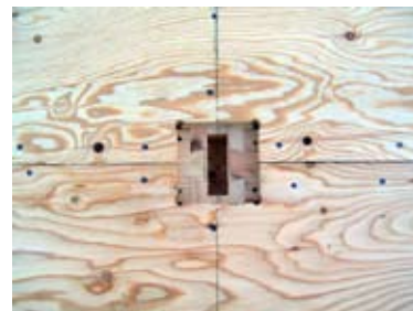
柱の欠き込みをプレカットした2階床合板
