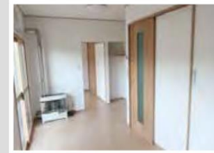
②段差解消(居間・洋室)
