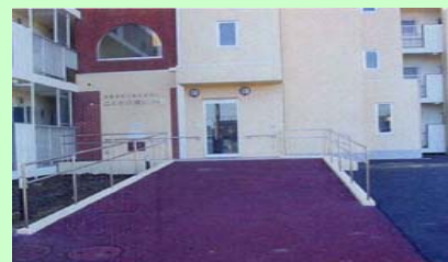
エントランス部分 (新たに設置されたスロープ)
