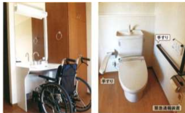
（建物内の様子）
