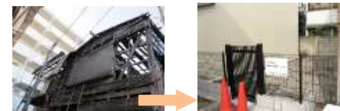
除却跡地を防災空地(墨田区)
