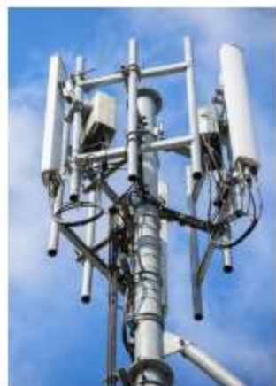
共有アンテナ設置
