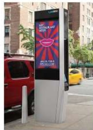
スマートポール設置
