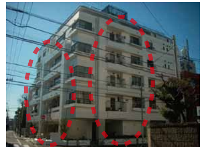
アウトフレーム工法による耐震補強
