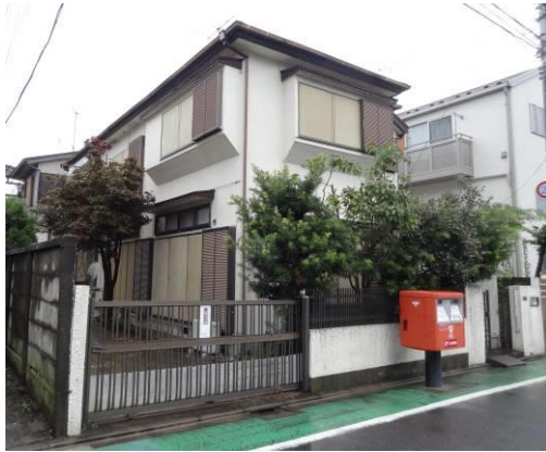
改修工事前(外観)
