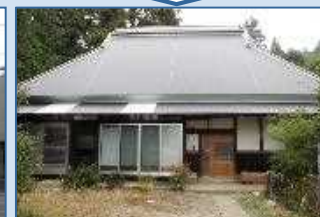
地域活性化のため、空き家を地域交流施設に活用
