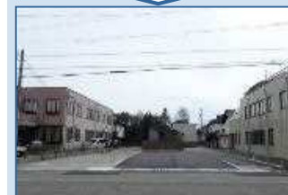
居住環境の整備改善のため、空き家・不良住宅を除却
