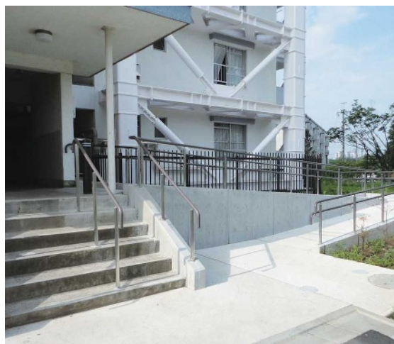
住棟の出入口のスロープ設置（多摩ニュータウン永山/東京都多摩市）
