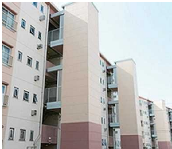
中層住棟に設置したエレベーター（相模台/神奈川県相模原市）
