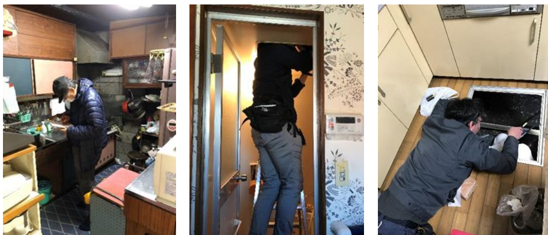
写真5、6、7（左、中央、右）：劣化診断の様子
